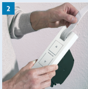
Gurtband einziehen und befestigen
