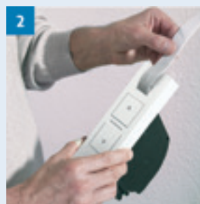
2 Gurtband einziehen und befestigen
