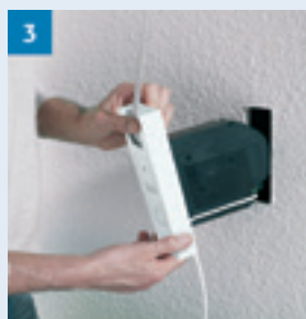
3 RolloTron einbauen
