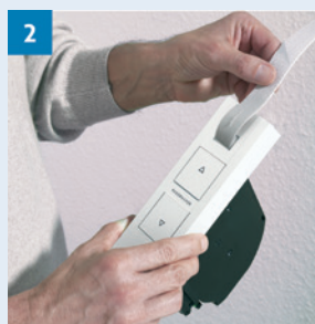
2 Gurtband einziehen und befestigen
