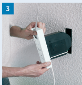
3 RolloTron einbauen
