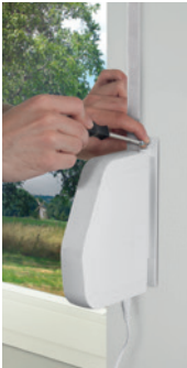
1. Manuellen Gurtwickler demontieren
