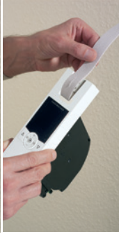
2. Gurtband einziehen und befestigen
