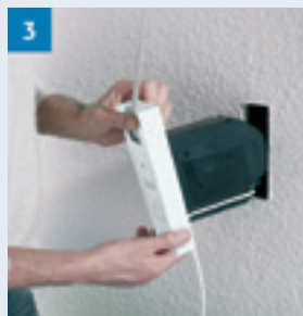
3 RolloTron einbauen
