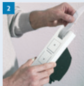
2 Gurtband einziehen und befestigen
