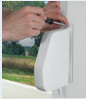
Manuellen Gurtwickler demontieren
