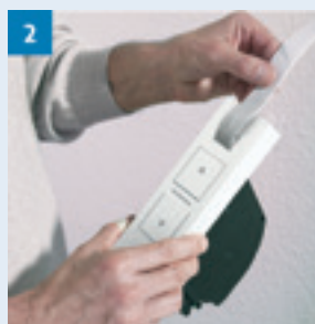
Gurtband einziehen und befestigen
