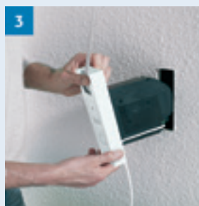
RolloTron einbauen
