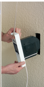
3. RolloTron einbauen
