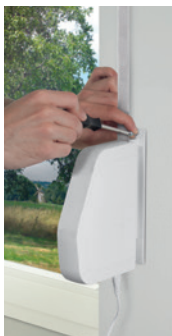
1. Manuellen Gurtwickler demontieren
